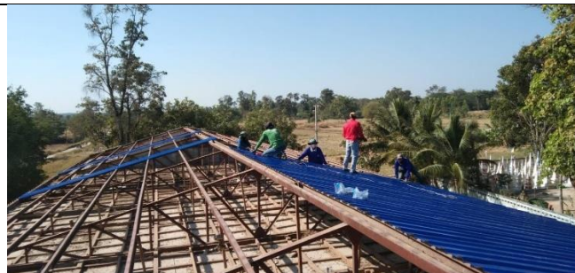
ปรับปรุงซ่อมแซมอาคารเรียน และบริเวณ
